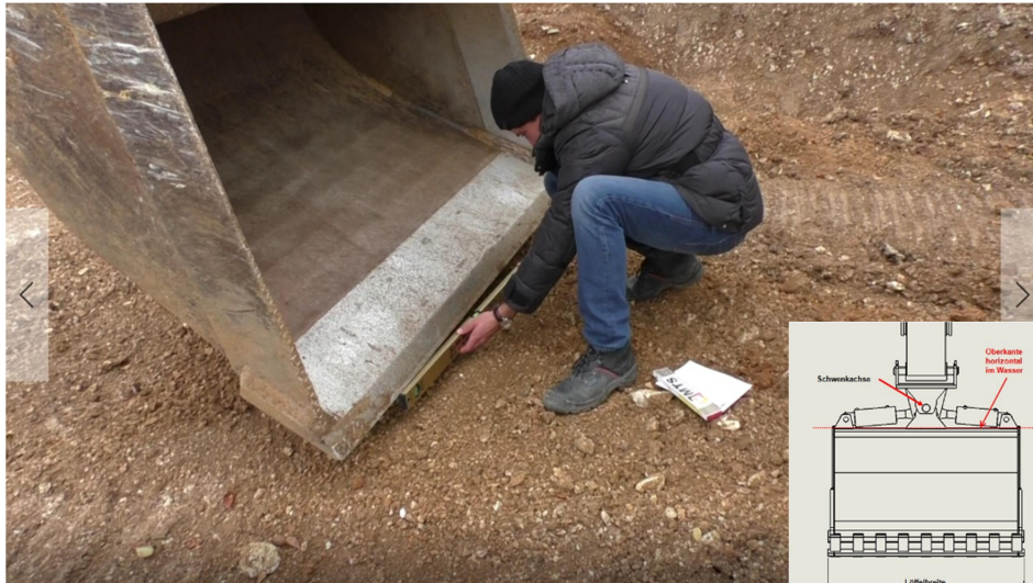
Abb.: 3: Ausrichten des Schwenklöffels mithilfe einer Wasserwaage.
