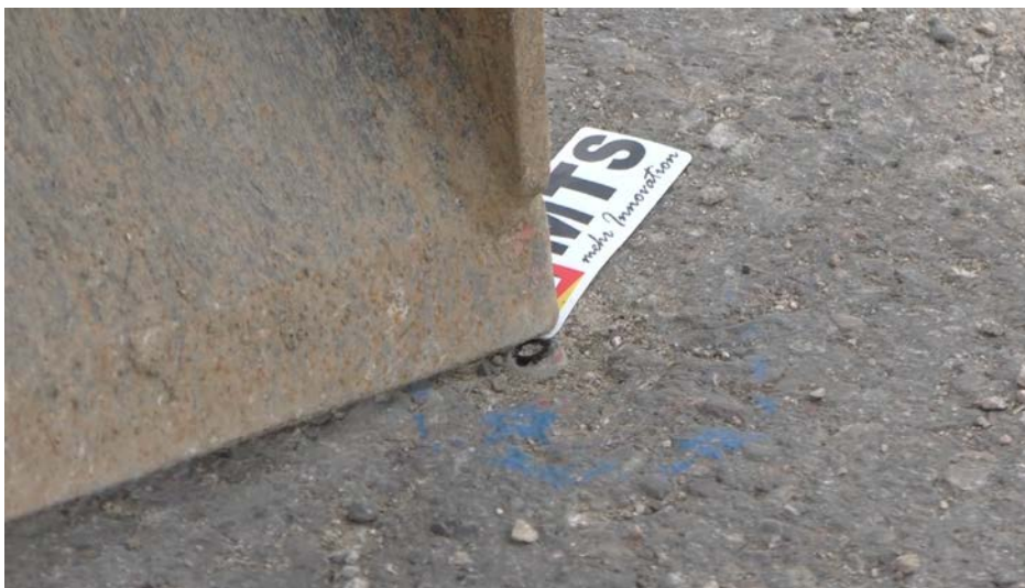
Abb.: 9: Nach dem Einmessen des Schwenklöffels müssen sie grundsätzlich einen bekannten Festpunkt auf der Baustelle anfahren um die Kalibrierung anhand der bekannten Koordinaten/Höhe des Festpunkts zu überprüfen.
