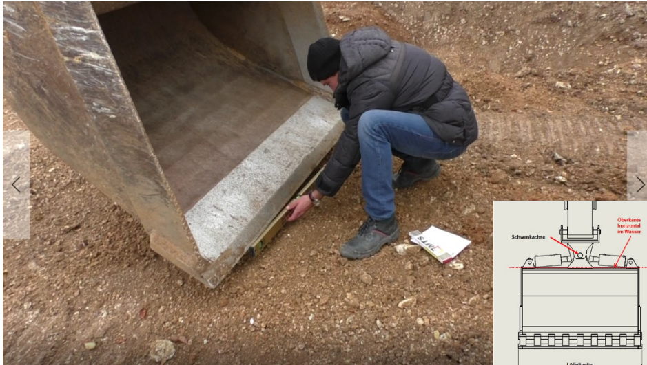
Abb.: 3: Ausrichten des Schwenklöffels mithilfe einer Wasserwaage.
