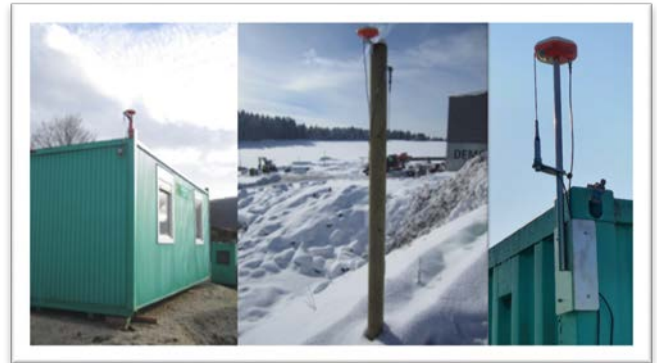
Abb. 4: Verschiedene Beispiele für den dauerhaften Aufbau einer Basis auf Baustellen.
